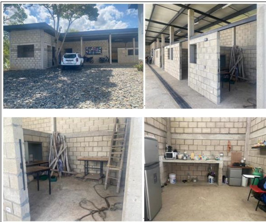
Fuente: Visita de campo-Instalaciones caseta de operación (Habitaciones, unidades sanitarias, salón de armamento) Elaboró: Leidy Cristina Marín Muñetón-Auditor P.U
